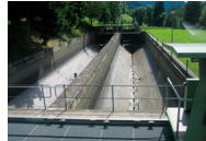
Photo du dessableur de la centrale de Mors
